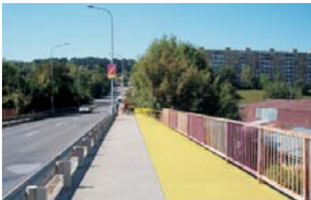
2 - radvanským viaduktom ponad Hron a diaľnicu, ale na konci viaduktu je len úzky chodník vedúci do križovatky
