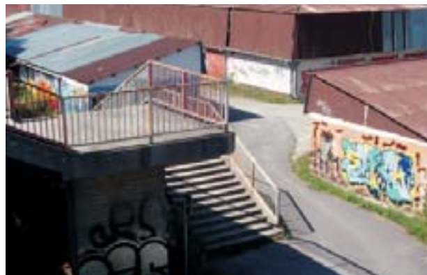
3 - na dočasnej cyklotrase je možné použiť toto schodisko, čo je síce bezpečné ale pre cyklistov veľmi zlé riešenie
