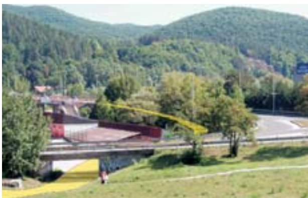
4 - vytvorením rampy pre cyklistov medzi cestou a garážami odstránime najväčšiu závalu z cyklotrasy
